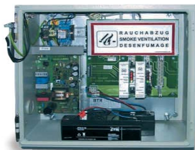
Rauchmeldeanlage mit integrierter CT Batterie
